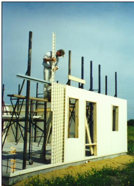
Por último, instale el revestimiento de muro (1377). (Consulte la sección 6 sobre la instalación de la armadura y los anclajes).
