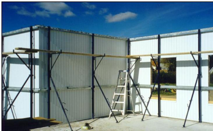
El sistema de andamiaje sirve para soportar los componentes de los muros y los trabajadores durante el vaciado del concreto. El sistema se compone de cinco elementos principales: la base de fijación, el soporte del andamiaje, el soporte de la plataforma, el puntal y el perfil de acero en Z.
