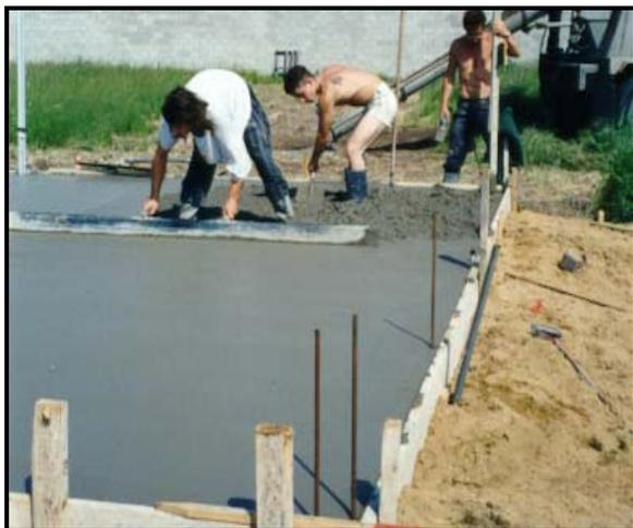
La losa de concreto constituye el principal cimiento de los muros de PVC. Este cimiento debe ser concebido y realizado de buena calidad.
