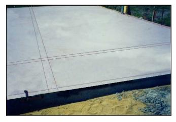
Trace el contorno de las soleras bajas exteriores, de modo que éstas queden en ángulo recto y centradas en la losa. Debe asegurarse de que las líneas sean trazadas correctamente utilizando el método de la hipotenusa.
