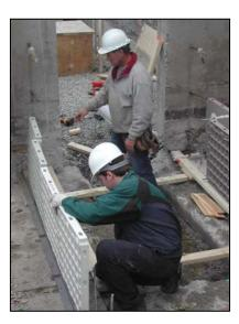
Instale algunos paneles y sujételos juntos. Abroche el espaciador I-210A con la varilla roscada a la junta de panel J-100A y a continuación, emperne el espaciador por el lado exterior del muro. Instale algunos refuerzos de acero en la parte superior y en la parte media del muro.
