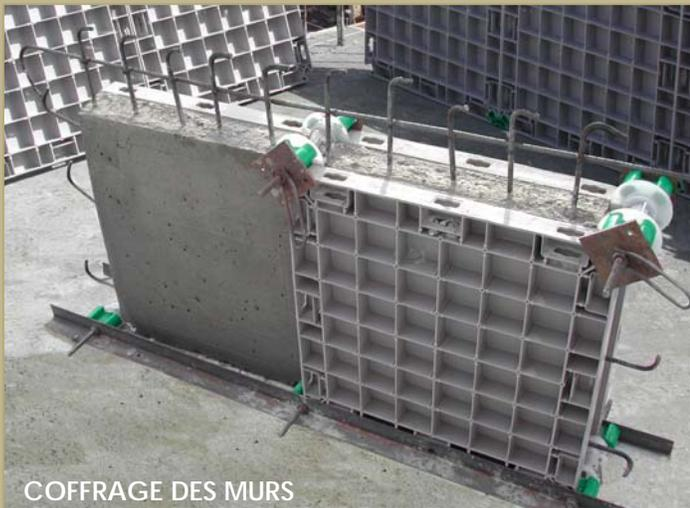
Le procédé de coffrage conçu et développé par DC INTERNATIONAL est modulaire et comporte plusieurs composantes de tailles variées, permettant d'ériger à peu près toutes grandeurs d'édifice en béton de un à quatre étages.
